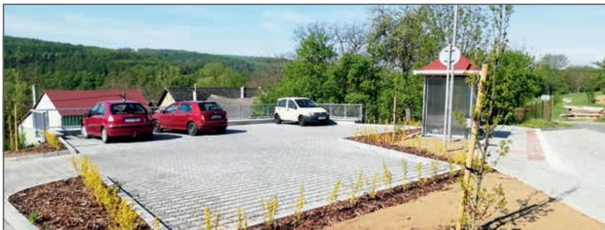
Parkoviště za zastávkou v Milovicích už je hotové, využívají je majitelé přilehlých domů.
