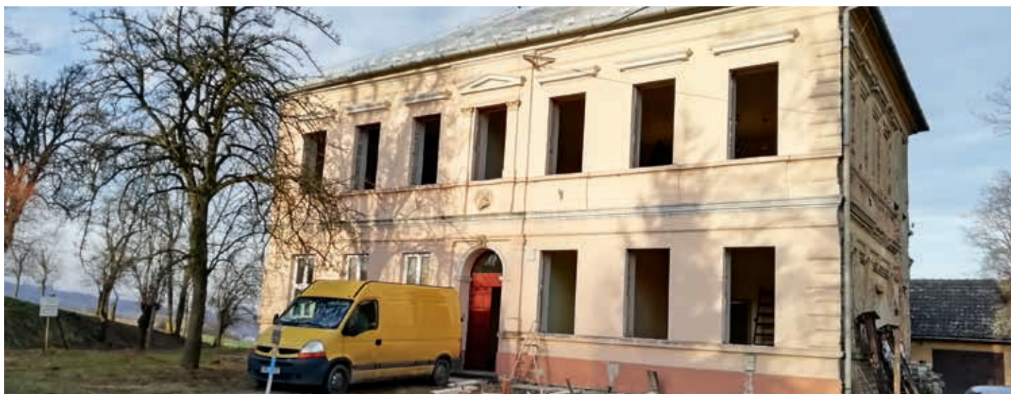
Výměna oken na budově bývalé školy v Soběsukách.
