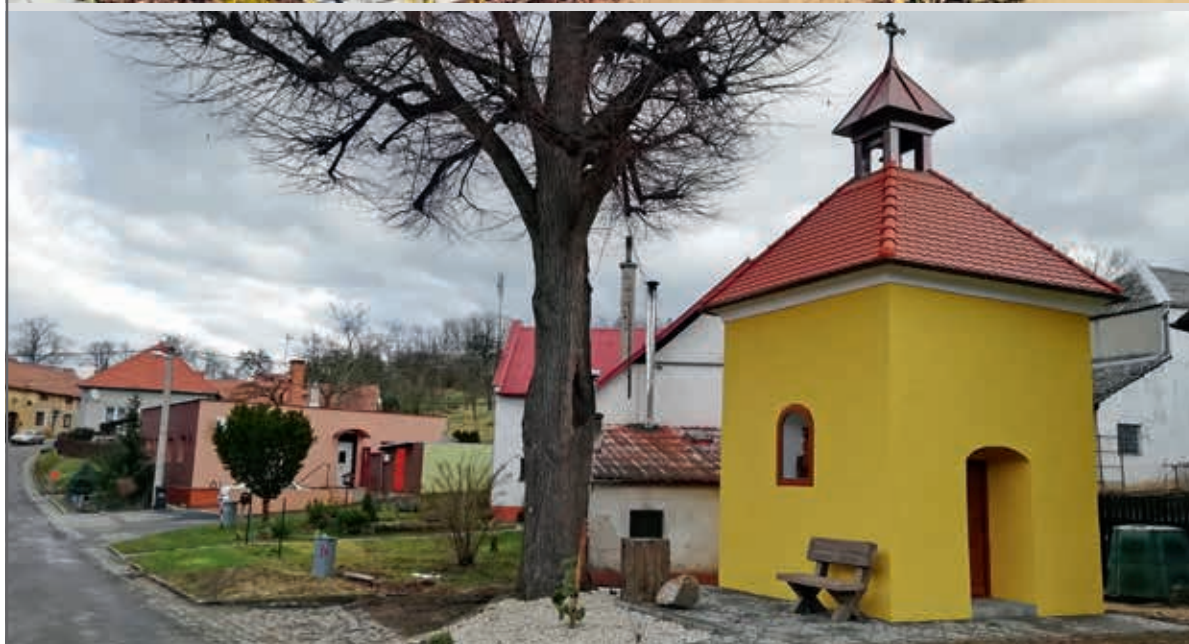
Dokončila se i rekonstrukce zvonice svatého Floriána.
